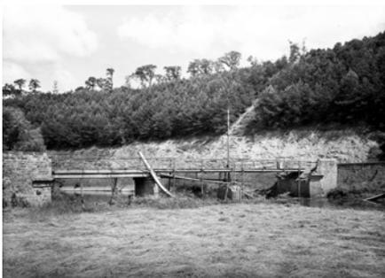
Am 9./10. September 1944 wurde die alte Steinbrücke von den abrückenden deutschen Truppen gesprengt. Bis zum Wiederaufbau musste eine Holzkonstruktion den zerstörten Teil ersetzen. Archiv Geschichtsfrënn vun der Gemeng Hesper GGH 6414
