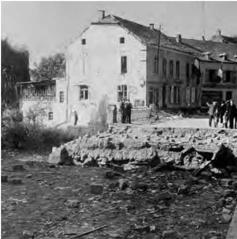
Die beiden Sprengungen in der Nacht vom 9. auf den 10. September 1944 hatten verheerende Schäden an der Alzette-Brücke in Hesperingen verursacht. Archiv Jules Braun (Hesperange)
