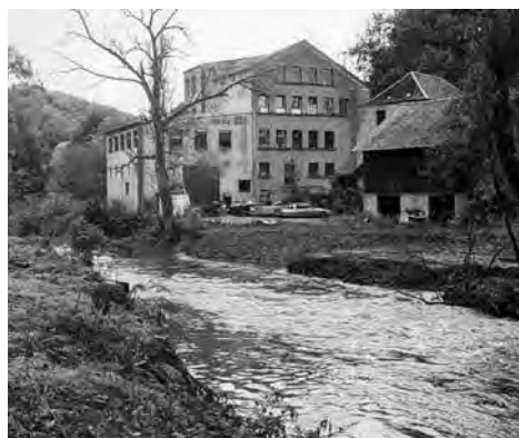
Im rückwärtigen Bereich des Gebäudes (auf dem Foto ganz rechts) befand sich früher ein Sägewerk (schon 1893 belegt). Foto von François Schroeder (Fentange)
