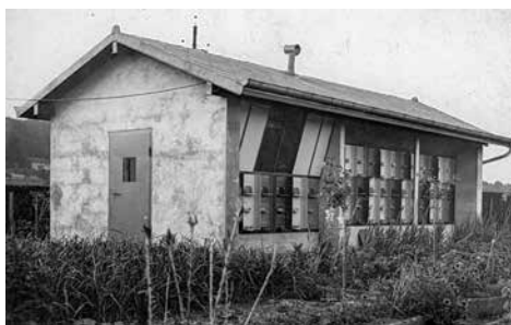
1954 ließ Justin Poos das neue Bienenhaus von dem Unternehmer Henri Groff aus Kopstal errichten.
